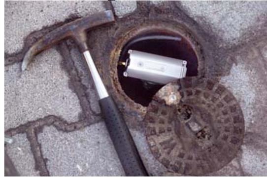
*SePem 01 instalado en posición horizontal*
