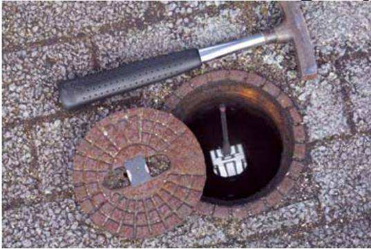
*SePem 01 instalado en posición vertical*
